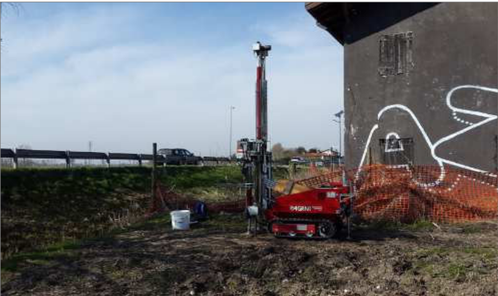
Immagine della fase di approntamento della Prova Penetrometrica Statica
